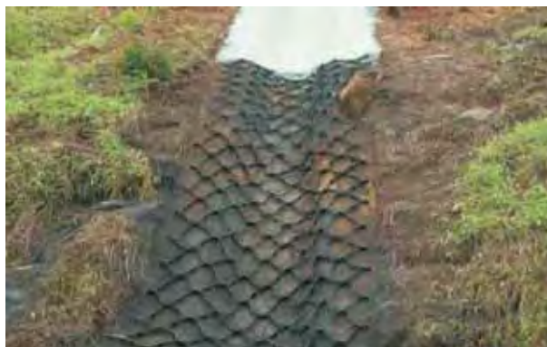
Figura 25 – Canaleta construída com geogrelha e concreto (COUTO et al, 2010).
