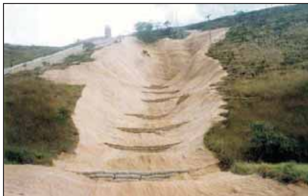
Figura 12 – Disposição de bermalongas perpendicularmente ao sentido do escoamento superficial (Fonte: Couto et al., 2010).
