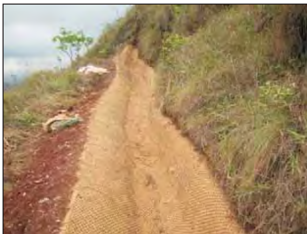
Figura 24 – Canaleta revestida com biomanta antierosiva (COUTO et al, 2010).
