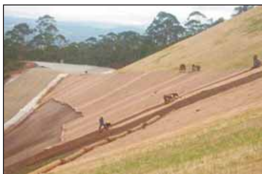
Figura 9 – Instalação de biomanta em talude de corte (Fonte: Couto et al., 2010).
