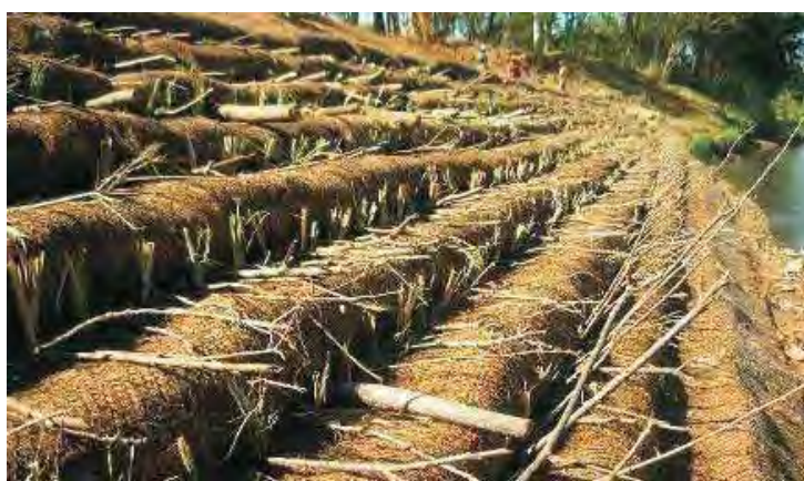
Figura 17 – Solo envelopado com estacas vivas e madeira (Fonte: Couto et al., 2010).
