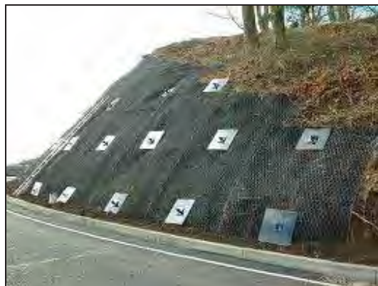
Figura 50 – Solo Grampeado em talude de encosta.
