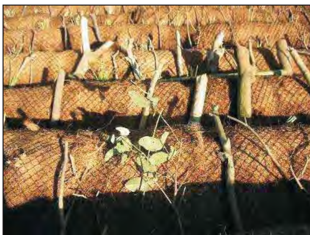
Figura 19 - Revitalização do solo utilizando madeira e estacas vivas – Santa Luzia-MG, Rio das Velhas (Fonte: Couto et al, 2010).
