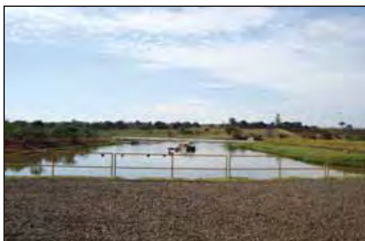
Figura 31 – Draga instalada no canal de adução da PCH Costa Rica.
