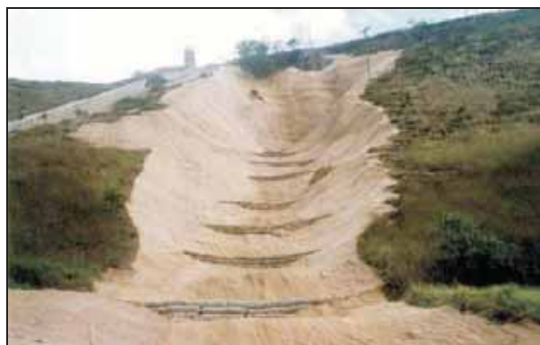
Figura 54 – Utilização de bermalongas como retentores de sedimentos.
