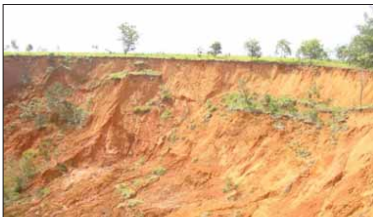
Figura 34 – Evidência de processos erosivos recentes na principal voçoroca da bacia contribuinte da PCH Costa Rica (MS).
