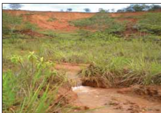
Figura 42 – Ocorrência de movimentos de massa, com deslizamento e carreamento de vegetação da borda da voçoroca, com fluxo superficial perene oriundo do afloramento do freático na encosta.
