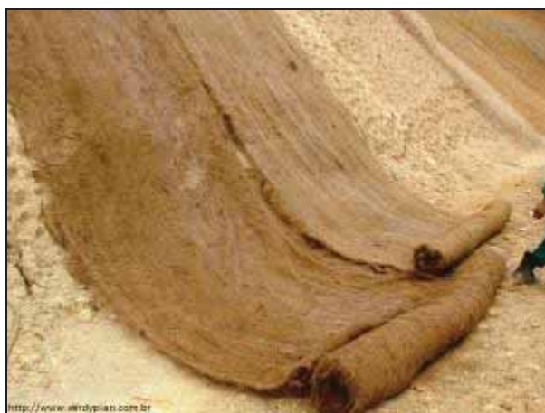
Figura 51 - Aplicação de biomanta na superfície do talude de encosta.
