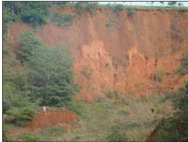
Figura 47 – Taludes de encosta na cabeceira da voçoroca.
