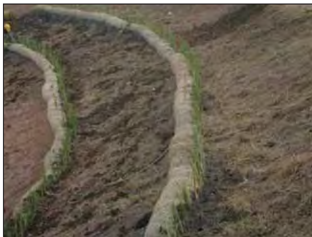
Figura 13 – Utilização de bermalongas associada ao plantio de capim Vertiver SP (Fonte: Couto et al., 2010).
